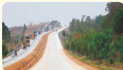
2013 - B'lore- Mysore Corridor Project
