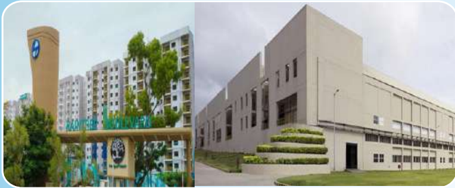
2020-L&T Raintree Boulevard, Bengaluru & Himatsingka Siede, Hassan
