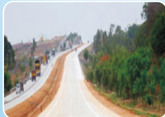
2013 - B'lore- Mysore Corridor Project
